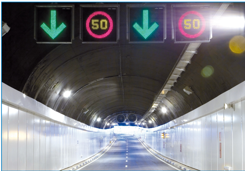
▲ Tronco central del túnel.
